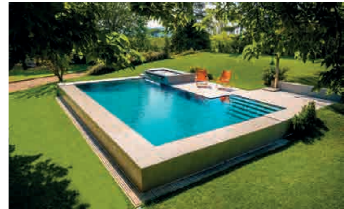
Pistoia Residenza privata, piscina seminterrata con sfioro a cascata che sfrutta la pendenza del terreno
